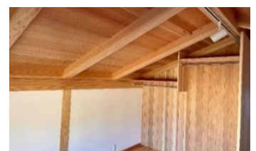
写真 3 スギ桎目板 3 層クロスパネル施工事例
