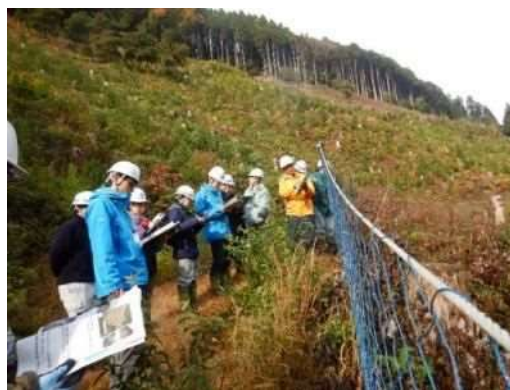
写真10 シカ生息状況に配慮して設置した防護柵
