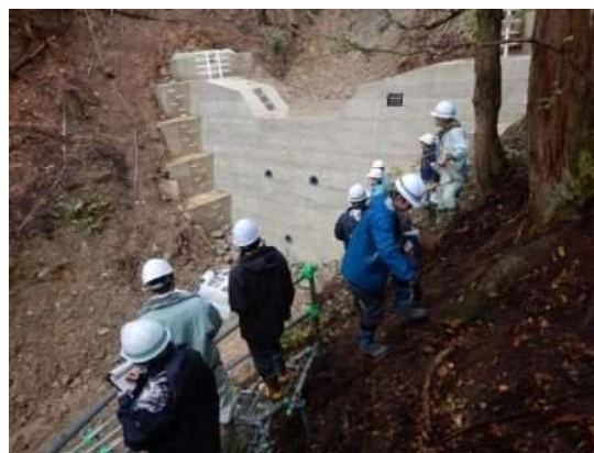
写真8 施工中の谷止工を確認
