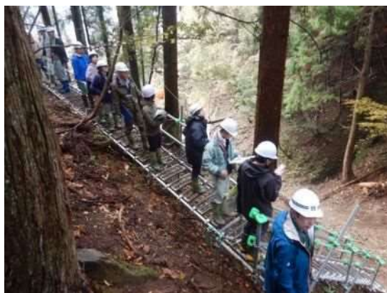
写真7 安全施工に配慮した仮設足場
