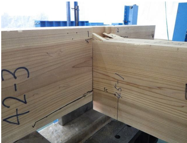
写真4 試験終了後の状況（試験体番号：3） 仕口部のめり込み、支持梁の割れ
