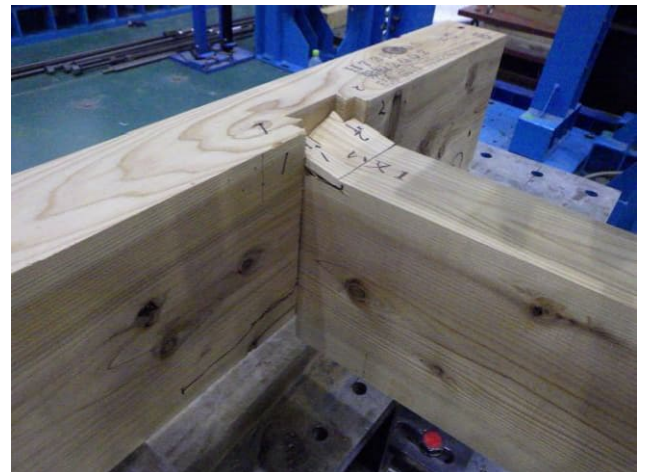
写真5 試験終了後の状況（試験体番号：4） 仕口部のめり込み，支持梁の割れ
