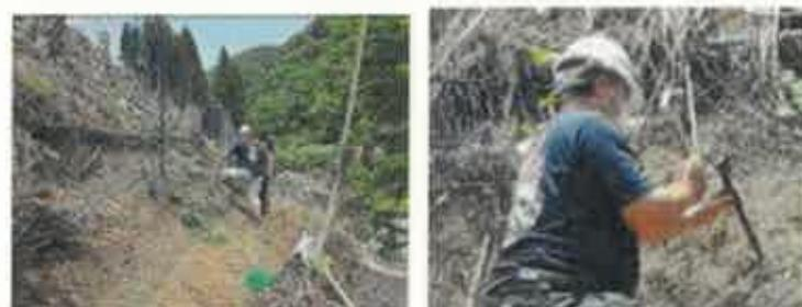
写真4 L字型スカートネットの施工状況（L字の踵部分にアンカーを打ち込みネットを密着）
