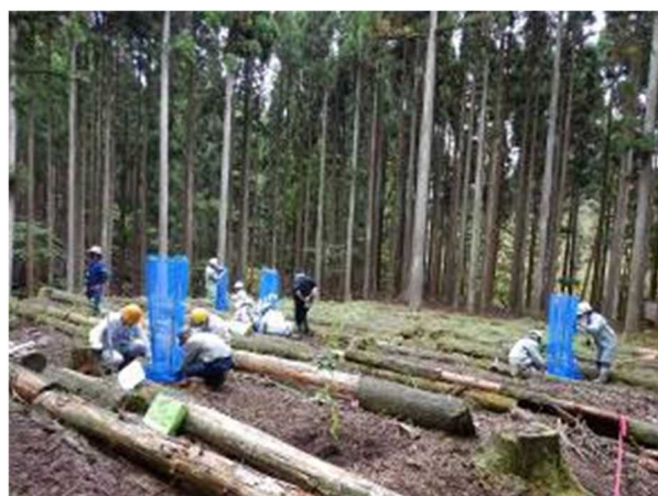
シカ防除資材設置状況
