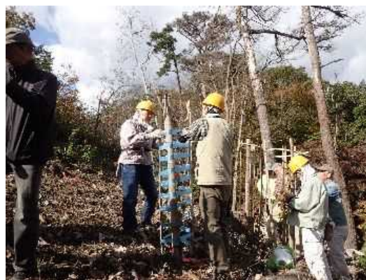
②竹支柱青テープ巻き
