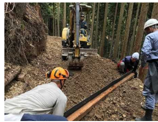
横断排水の設置
